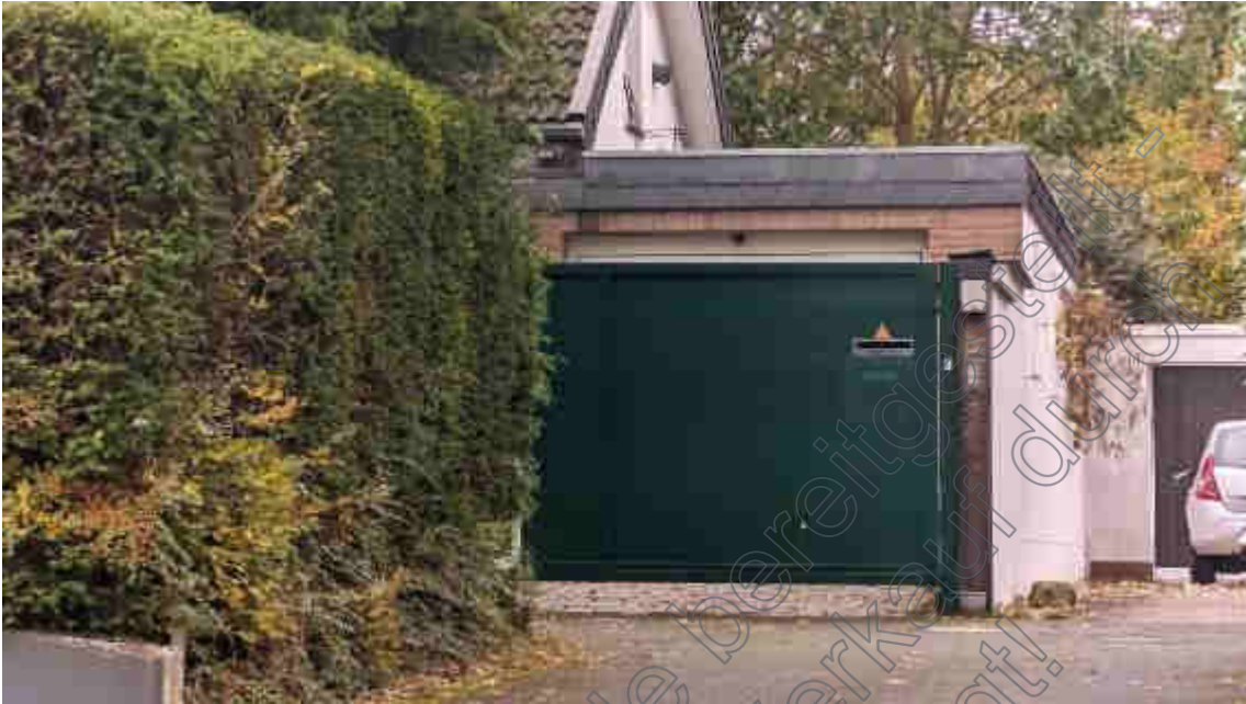
Bild B3 exemplarische Teilausschnitt des Gebäudes
