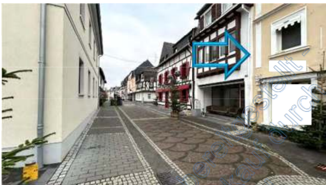
Bild A1 Blick in die Erschließungsstraße
