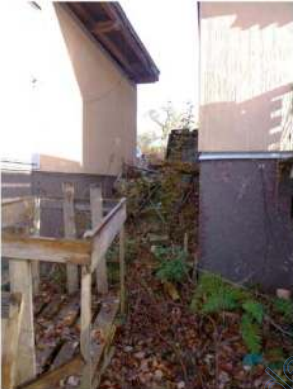
19 a Treppe zw. Haus und Garage
