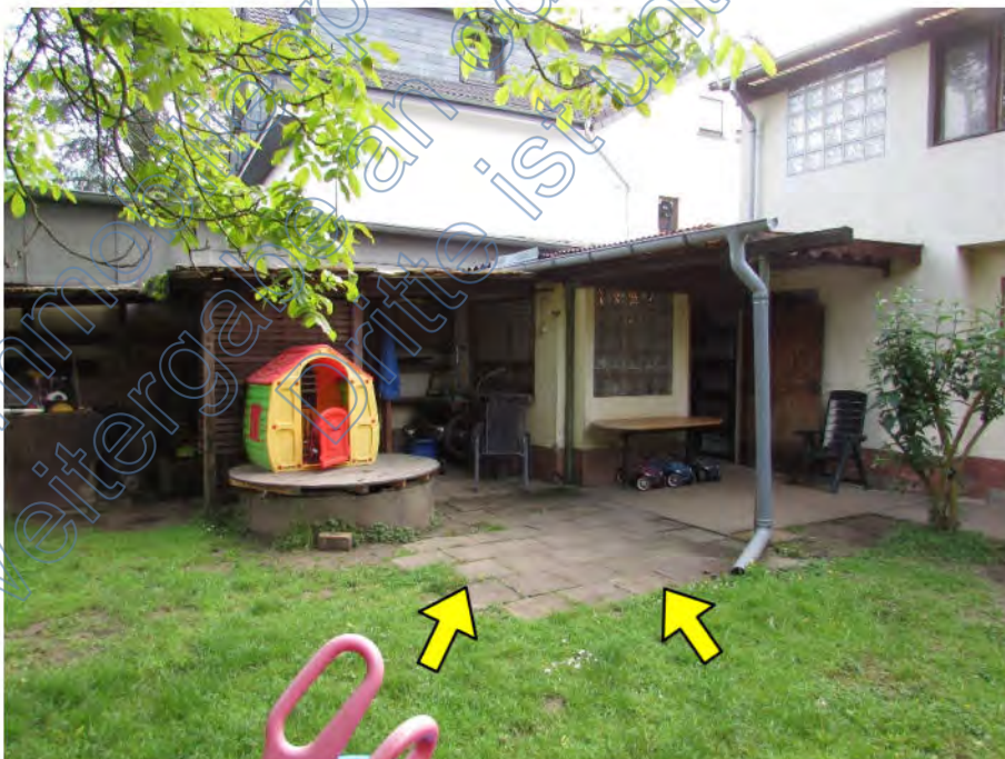
Foto 12: Abstellraum-Anbau mit rückwärtig angeschleppten Überdachungen, abgesetzte Betonplattenbefestigung
