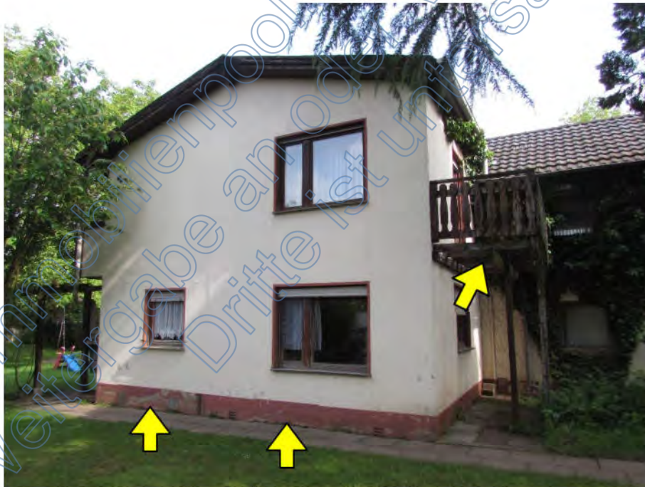
Foto 6: Wohnhaus, Süd-Ansicht: Feuchtigkeit und abplatzender Farbanstrich im Fassadensockelbereich, Reste eines früheren Holzbalkons
