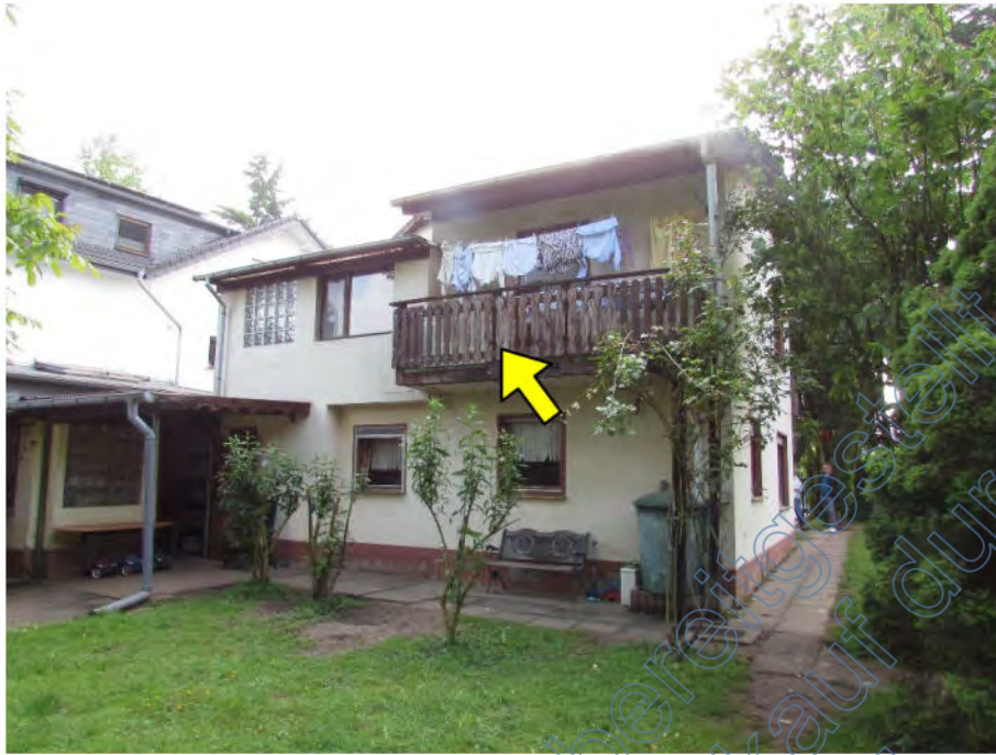
Foto 3: Wohnhaus, rückwärtige/West-Ansicht: verwittertes Balkongeländer
