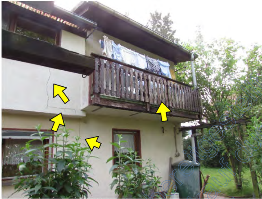
Foto 5: Wohnhaus, rückwärtige/West-Ansicht: Risse in der Fassade, verwittertes Balkongeländer
