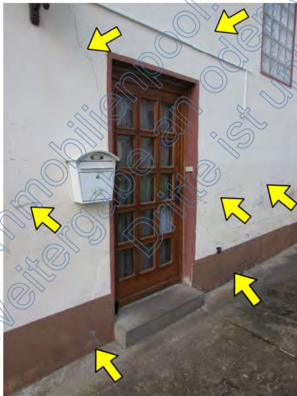
Foto 2: Wohnhaus, Hauseingang: Risse im Fassadenbereich, abblättrener Farbanstrich
