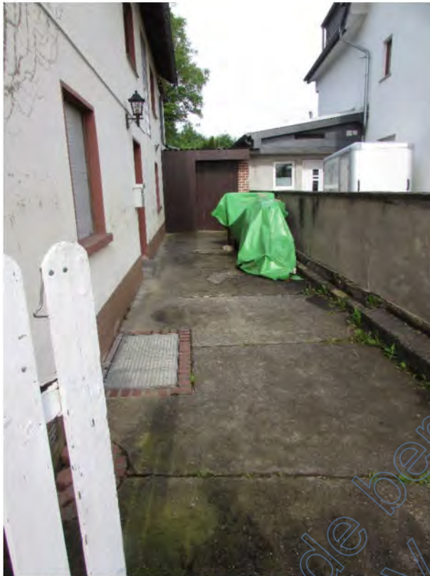
Foto 11: Zugang: verwitterte/schadhafte Betonbefestigung; hinten: Abstellraum-Anbau
