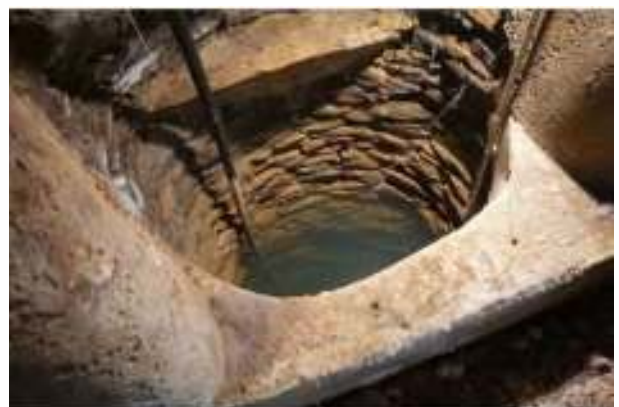
gemauerter Brunnen im Kellergeschoss
