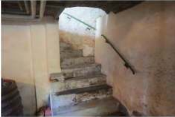
Treppe zum Erdgeschoss
