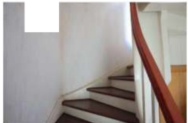
Treppe zum Obergeschoss
