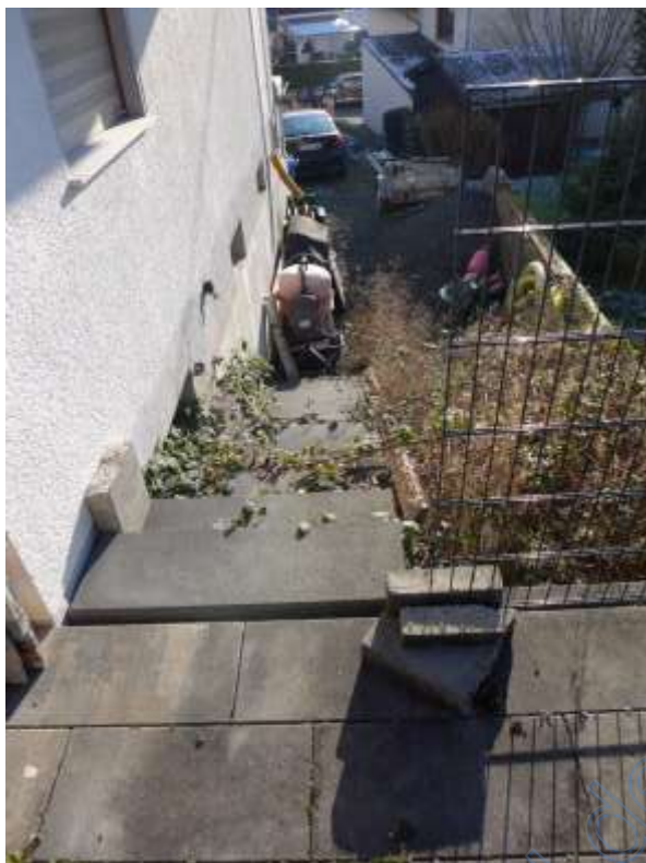
7 a seitliche Terrassentreppe
