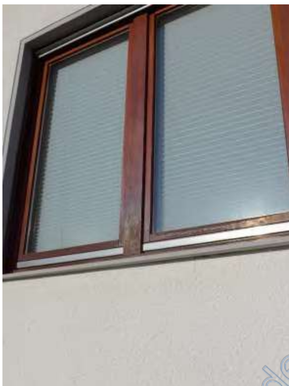
27 a Zustand der älteren Fenster
