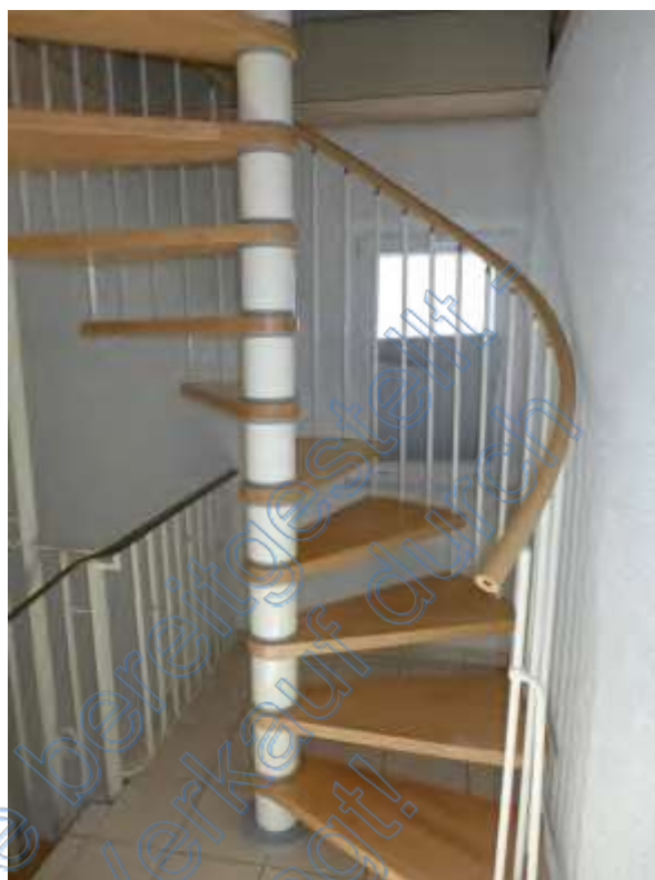
17 b Treppe zum Spitzboden
