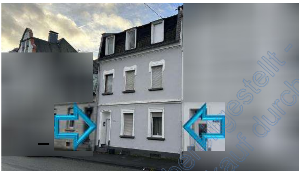
Bild B3 Straßenansicht
