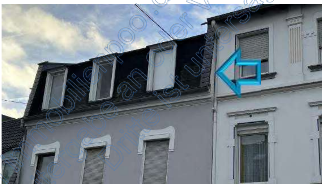
Bild B6 Teilausschnitt Dach
