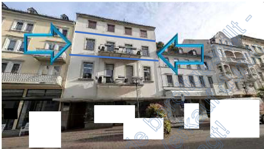
Bild B1 exemplarische Gebäudeansicht
