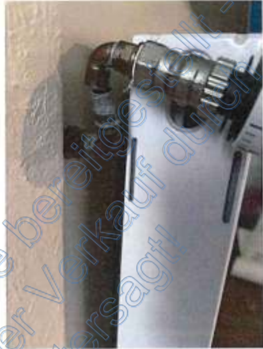
beschädigte Heizrohrleitung
