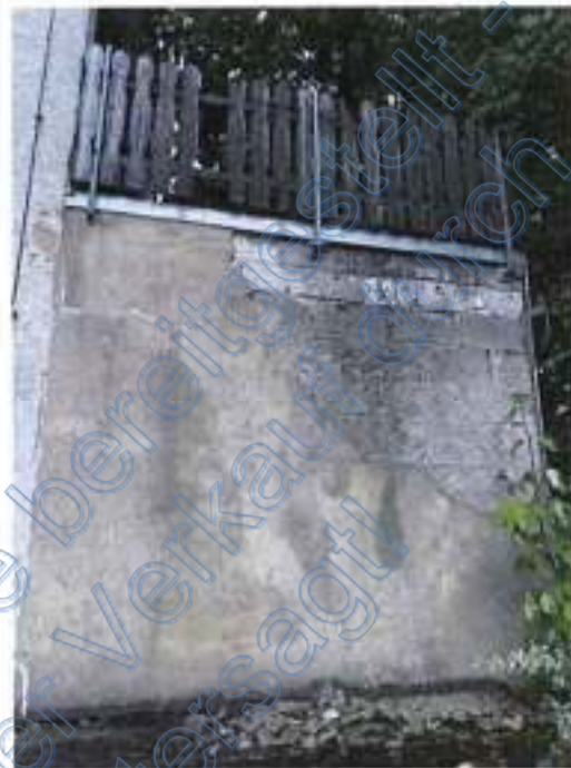
Beschädigte Putzfassade
