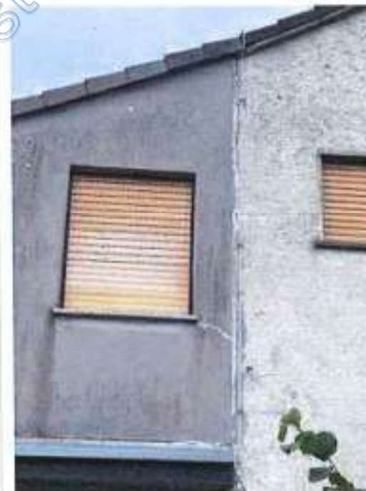
Riss durch Gebäudeabsenkung
