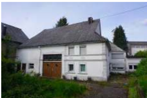
straßenseitige Ansicht von Südwesten auf das Anwesen
