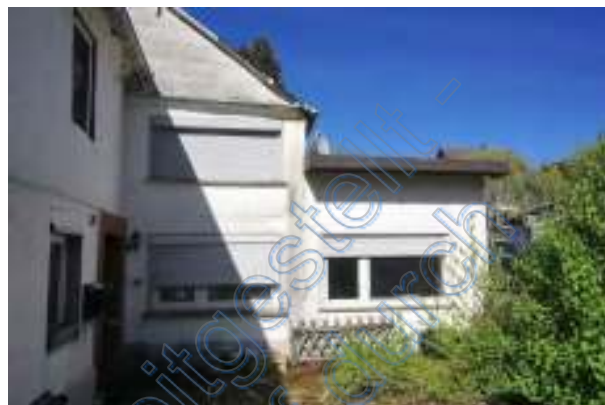
Anbauten neben dem Wohngebäudeteil
