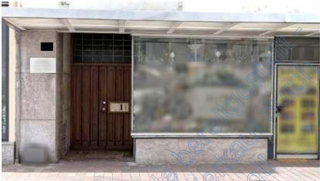
Bild B3 Eingangsbereich
