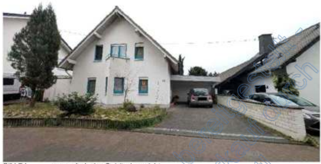
Bild B1 exemplarische Gebäudeansicht
