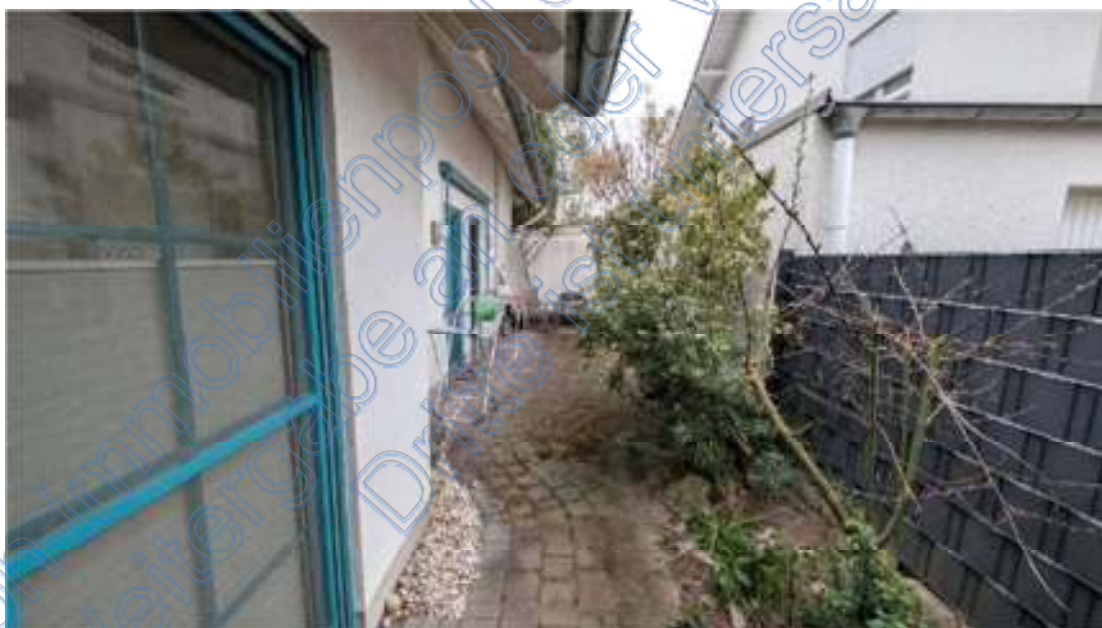
Bild B4 exemplarische Gebäudeansicht
