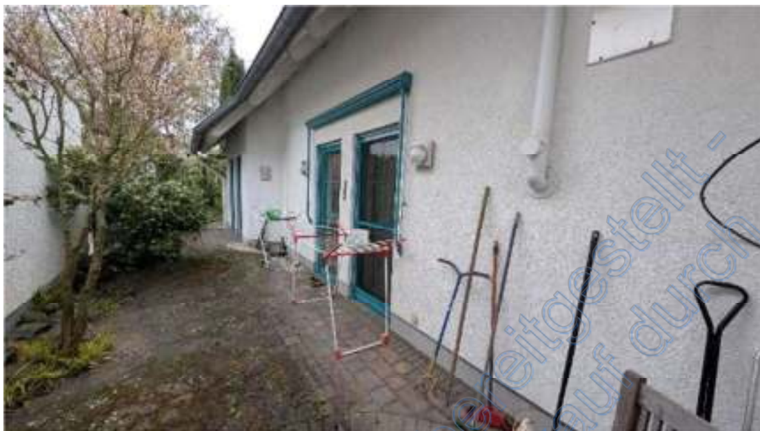
Bild B3 exemplarische Gebäudeansicht
