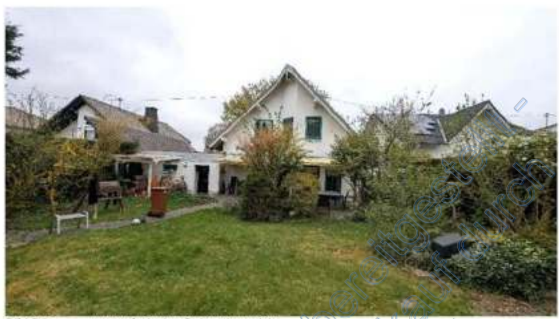
Bild B5 exemplarische Gebäudeansicht
