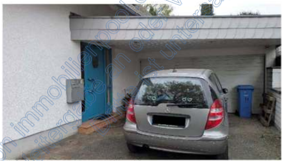
Bild B6 Eingangsbereich mit Blick auf Garage
