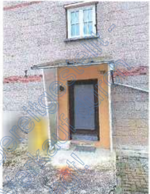
Bild 10 Der Eingangsbereich zur Einheit I im Erdgeschoss befindet sich giebelseitig.
