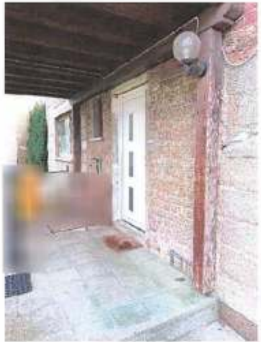
Bild 8 Die Hauseingangstür zu Einheit II im Obergeschoss.
