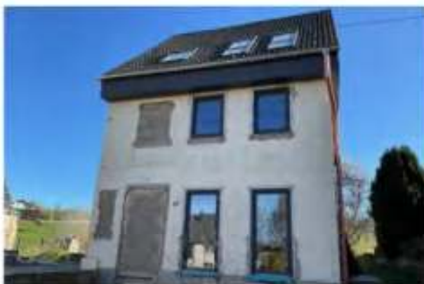
Ansicht von Norden auf das bestehende Wohnhaus
