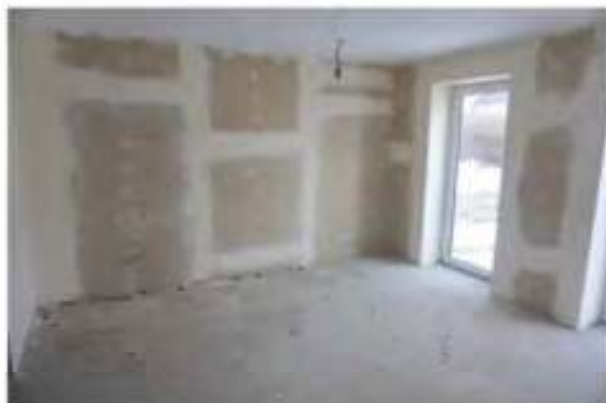
Zimmer im Erdgeschoss des Wohnhauses (Wohnung Nr. 1)
