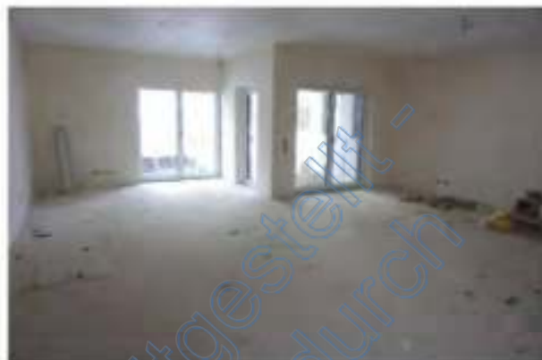
Wohnraum im Erdgeschoss des Anbaus (Wohnung Nr. 1)
