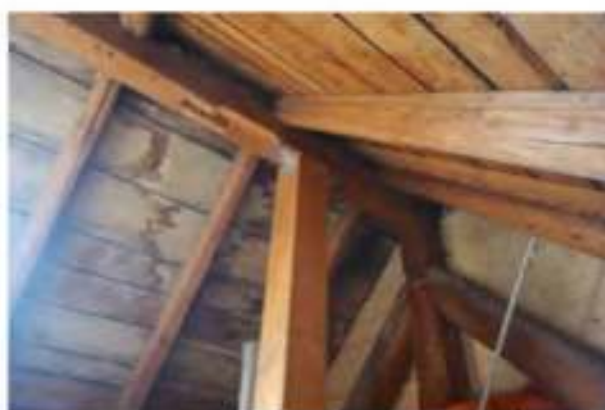
Blick in den Dachstuhl
