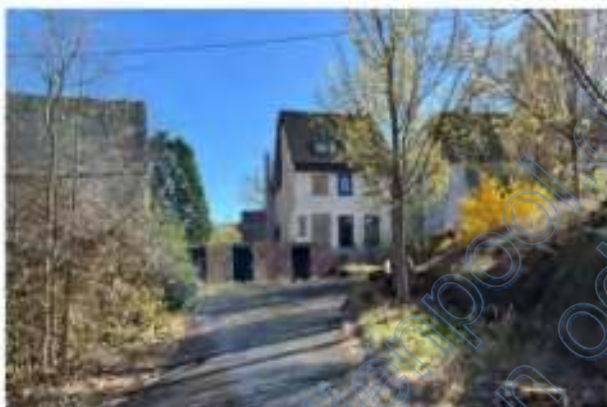
Zufahrt von der Straße zu den Gebäuden
