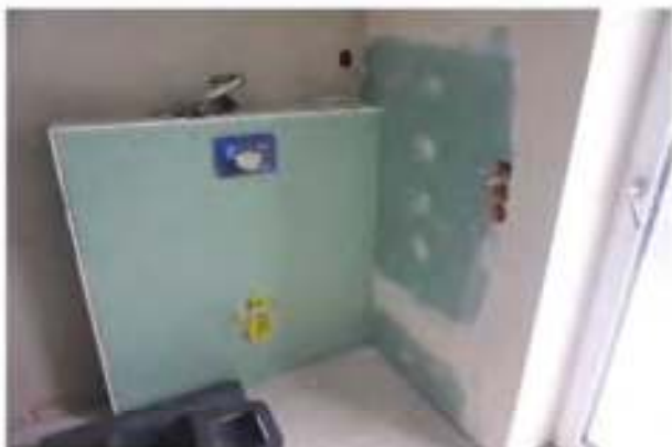
Bad im Obergeschoss des Wohnhauses (Wohnung Nr. 1)
