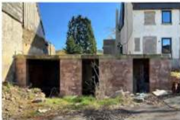
Rohbau des Untergeschosses des geplanten Mehrfamilienhauses
