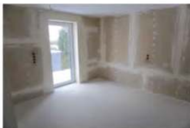
Zimmer im Obergeschoss des Wohnhauses (Wohnung Nr. 1)
