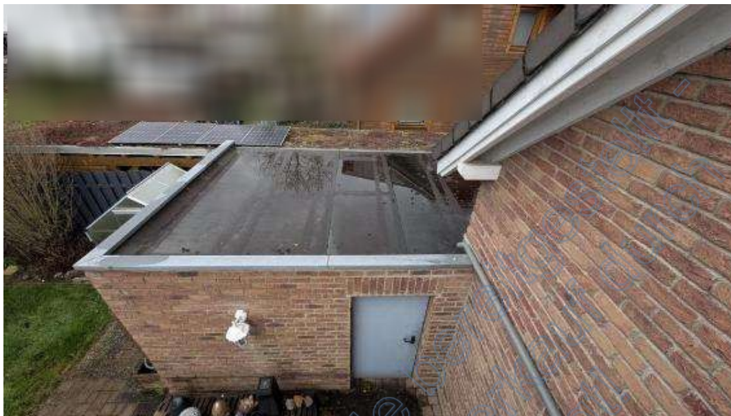
Bild B8 Dachansicht Garage
