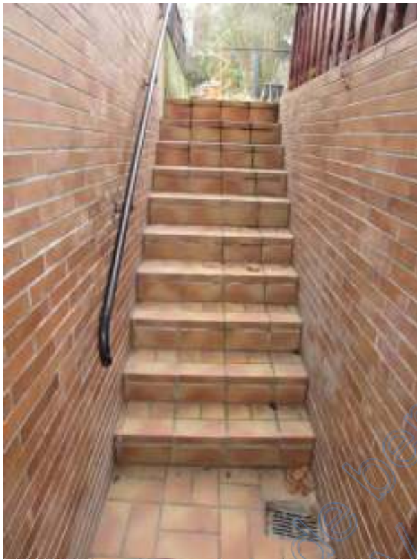
Foto 11: Außentreppe vom Erdgeschoss zum rückwärtigen Grundstücksbereich (Garten)
