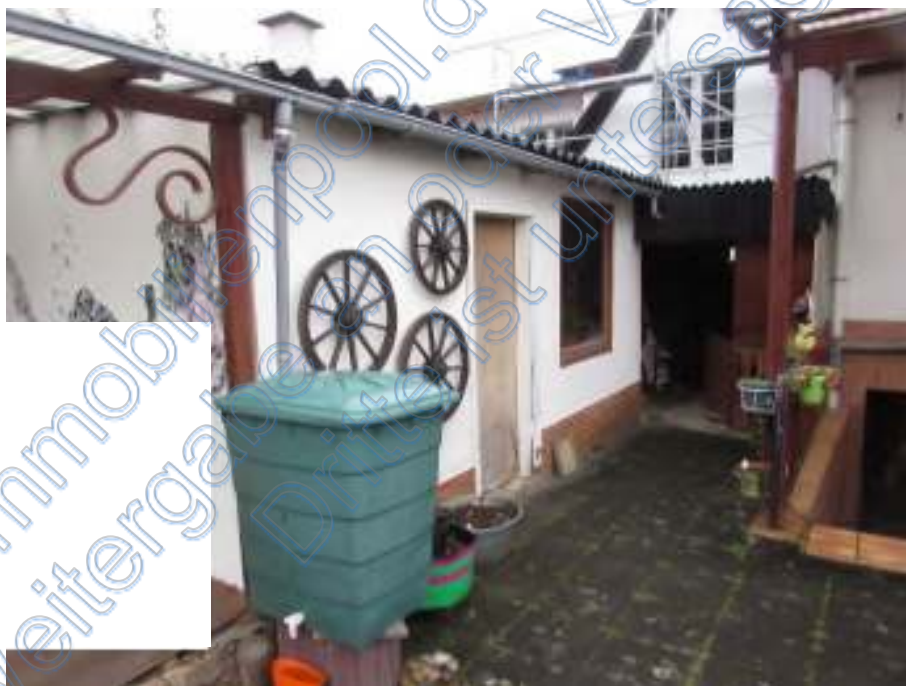
Foto 14: massiver Schuppen, angrenzender Holzschuppen
