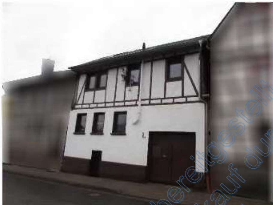
Foto 1: Straßenansicht (Altbau mit der nicht im Rahmen dieses Gutachtens zu bewertenden Wohnung Nr. 2, Tordurchfahrt als Zugang zu der zu bewertenden Wohnung Nr. 1)
