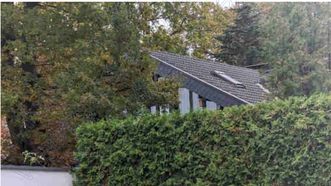
Bild B4 exemplarische Teilausschnitt des Gebäudes
