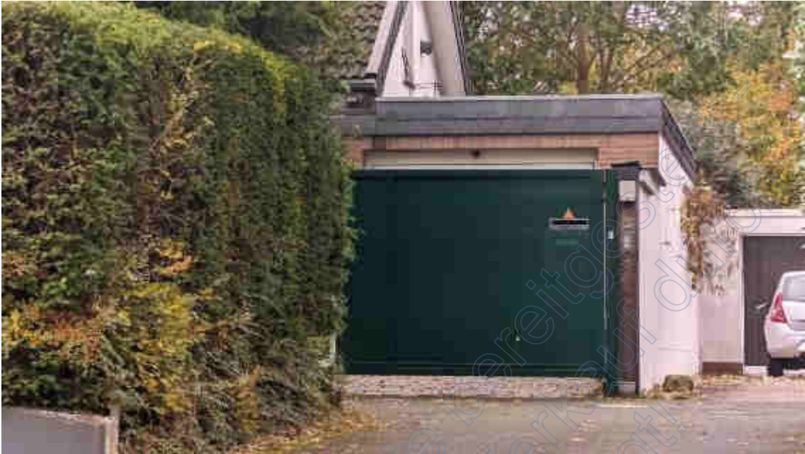
Bild B3 exemplarische Teilausschnitt des Gebäudes
