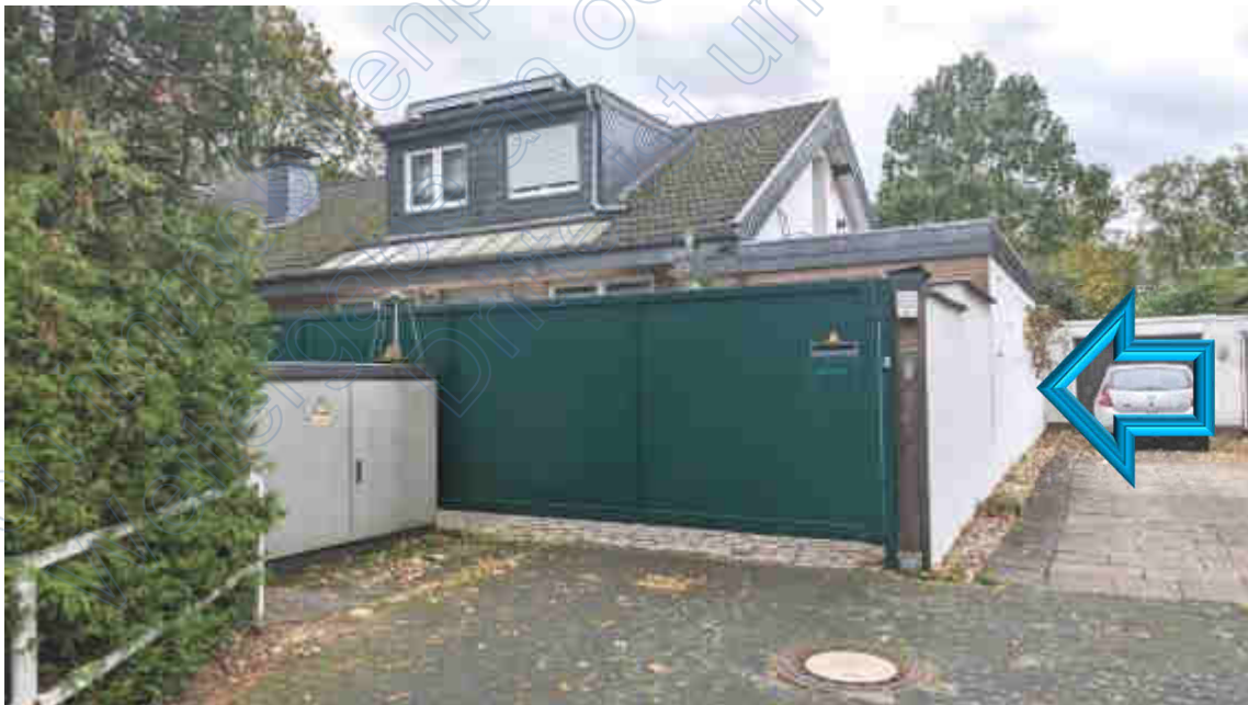
Bild B2 exemplarischer Teilausschnitt des Gebäudes
