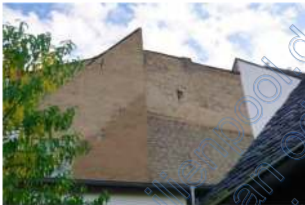
rückseitige Ansicht von Norden auf das Wohnhaus
