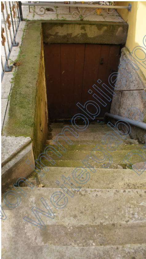
Außenansicht: Eingang zum Gewölbekeller
