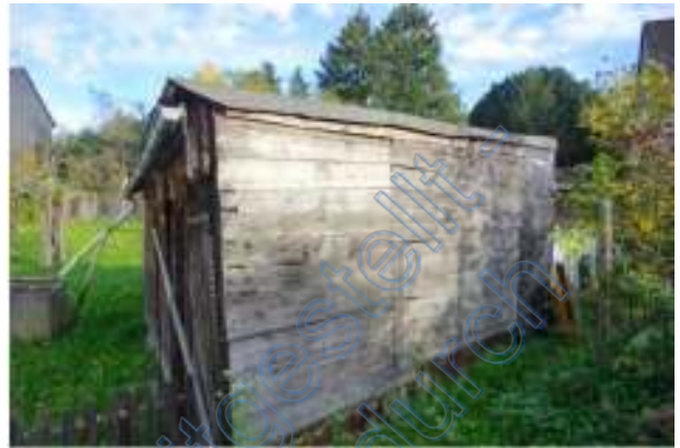
Holzschuppen auf dem Grundstück Flur 13 Flurstück 872/42
