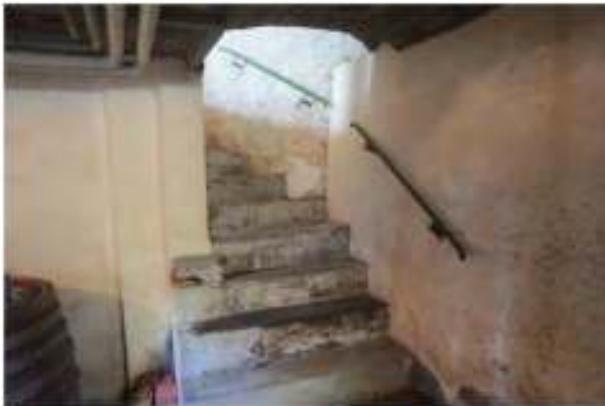
Treppe zum Erdgeschoss
