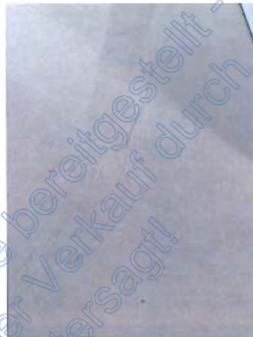
Abriebspuren aufgrund von schleifenden Türen
