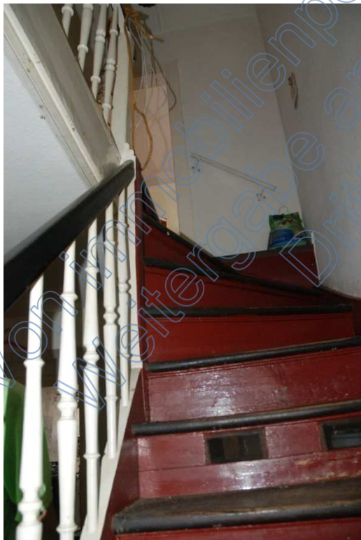
Detail Treppe zum DG
