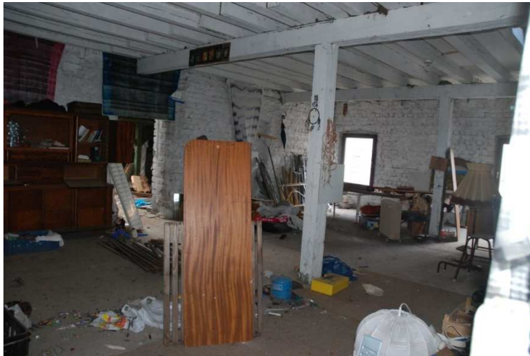
Innenansicht Lager OG
