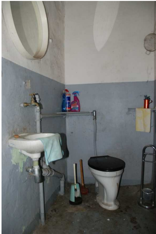
Detail WC und Waschbecken
