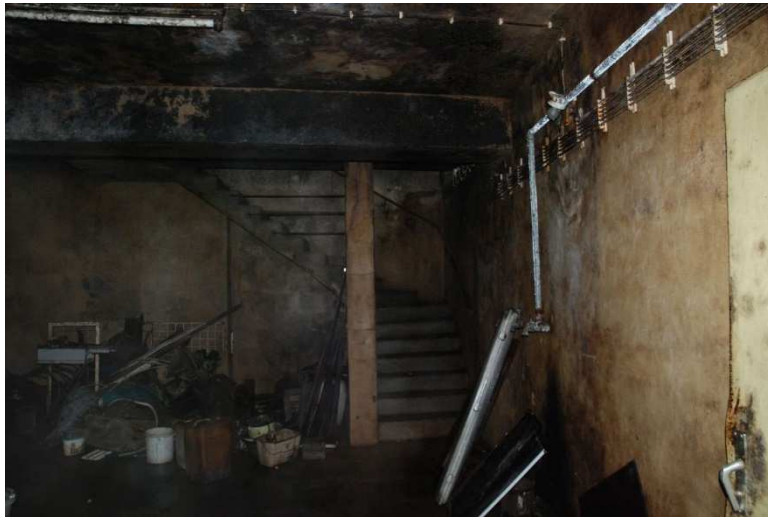
Innenansicht Keller mit Treppe zur Packhalle EG
