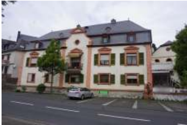
straßenseitige Ansicht von Süden auf das Wohn- und Geschäftshaus
