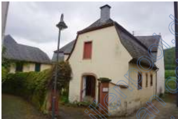
Blick vom Marktplatz auf den Seitenflügel des Wohn- und Geschäftshauses
