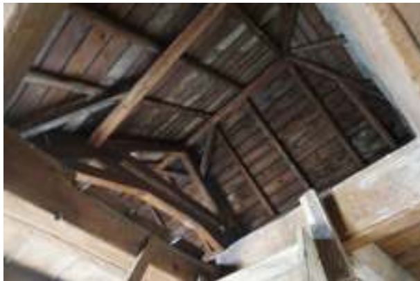
Blick in den Dachstuhl des Wirtschaftsgebäudes
