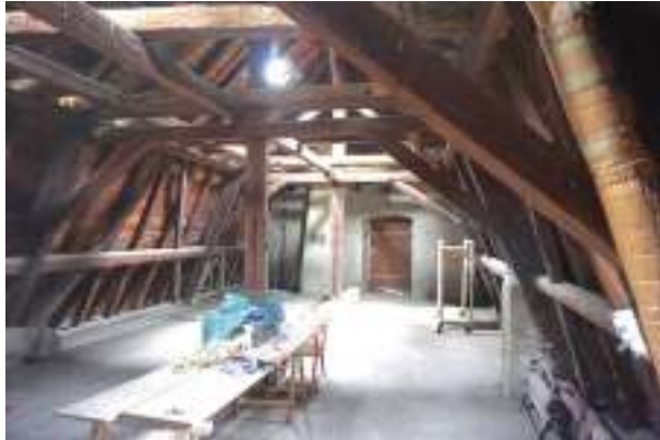
nicht ausgebautes Dachgeschoss im Seitenflügel
