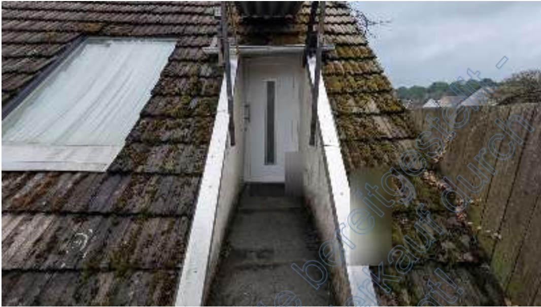
Bild B13 Zugang Dachgeschoss Scheune
