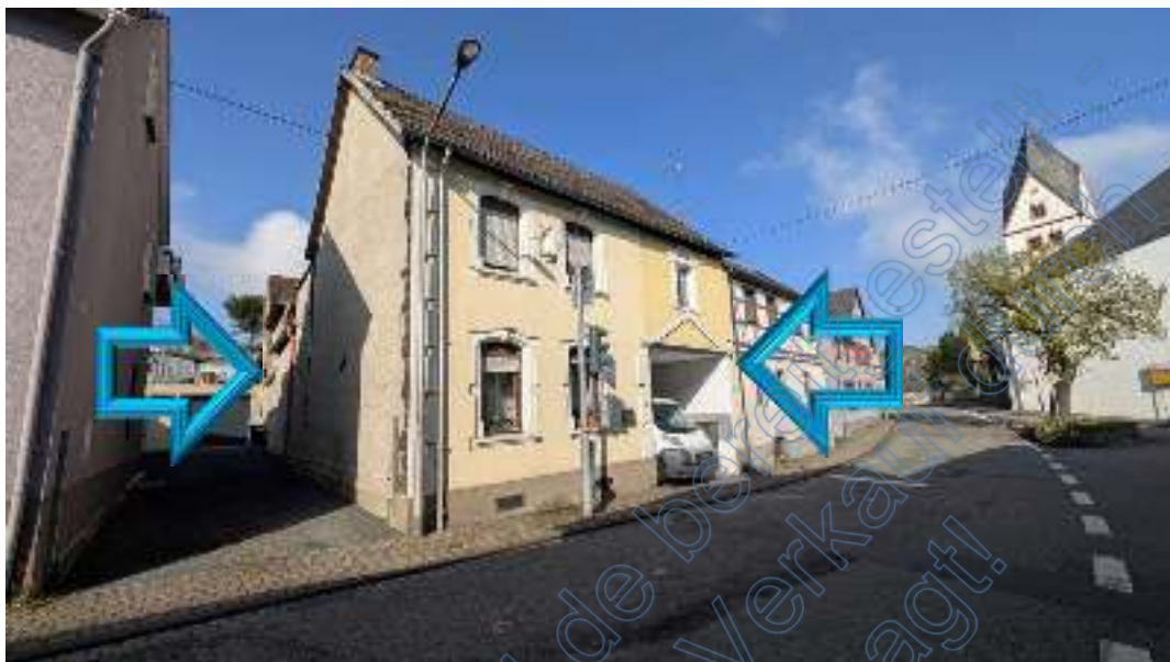
Bild B1 Straßenansicht
