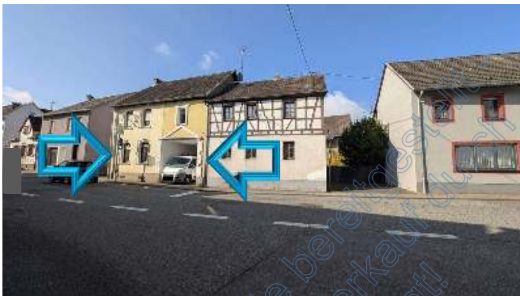
Bild B3 Straßenansicht
