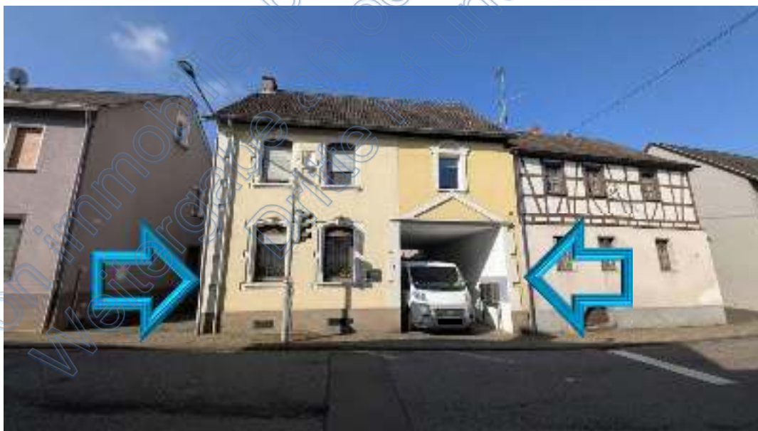
Bild B2 Straßenansicht
