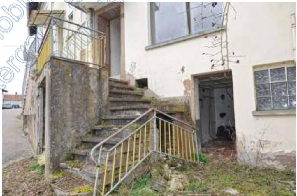
BILD 04 ANSICHT WEST - EBENERDIGER KELLER & BAUFÄLLIGE ZUGANGSTREPPE ZUM ERDGESCHOSS -
