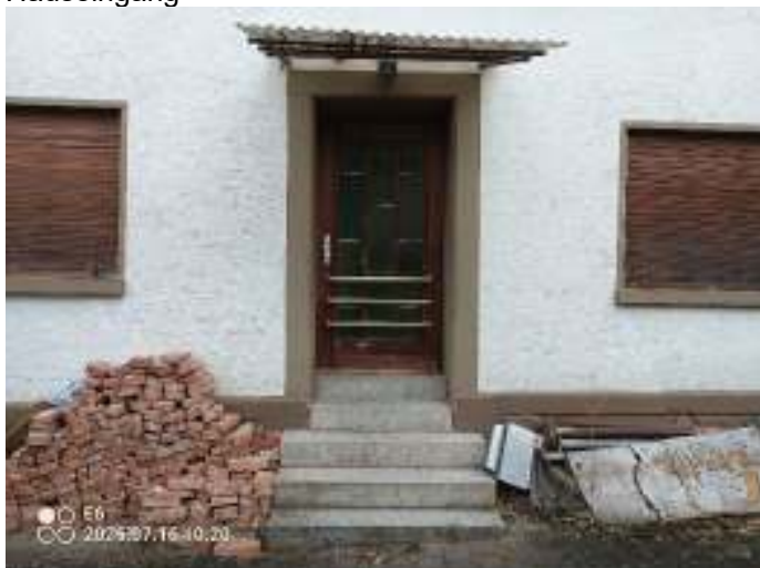
Haustür mit provisorischer Fußschwelle
