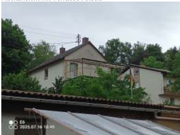
Rückansicht mit Terrasse Anbau
