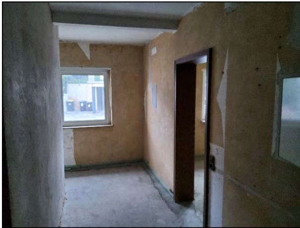
Bild 13: EFH Flur OG (Rohbau)
