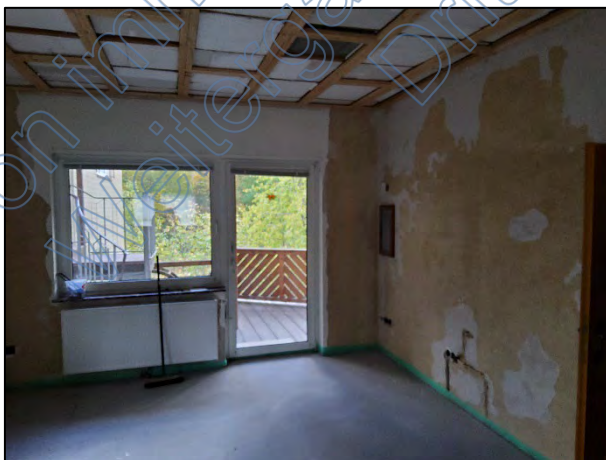
Bild 11: EFH Zimmer EG (Rohbau)
