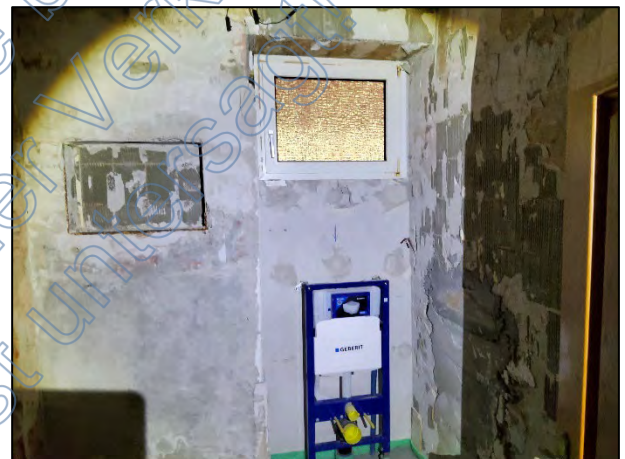
Bild 10: EFH Bad EG (Rohbau)
