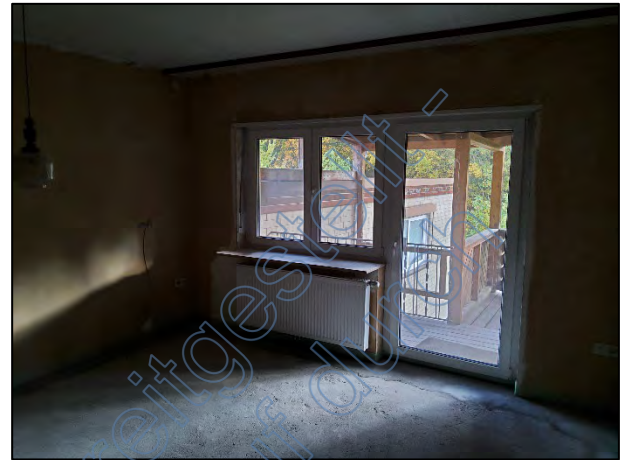
Bild 14: EFH Zimmer OG (Rohbau)
