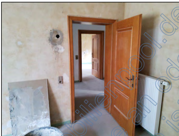
Bild 9: EFH Zimmer/Flur EG (Rohbau)
