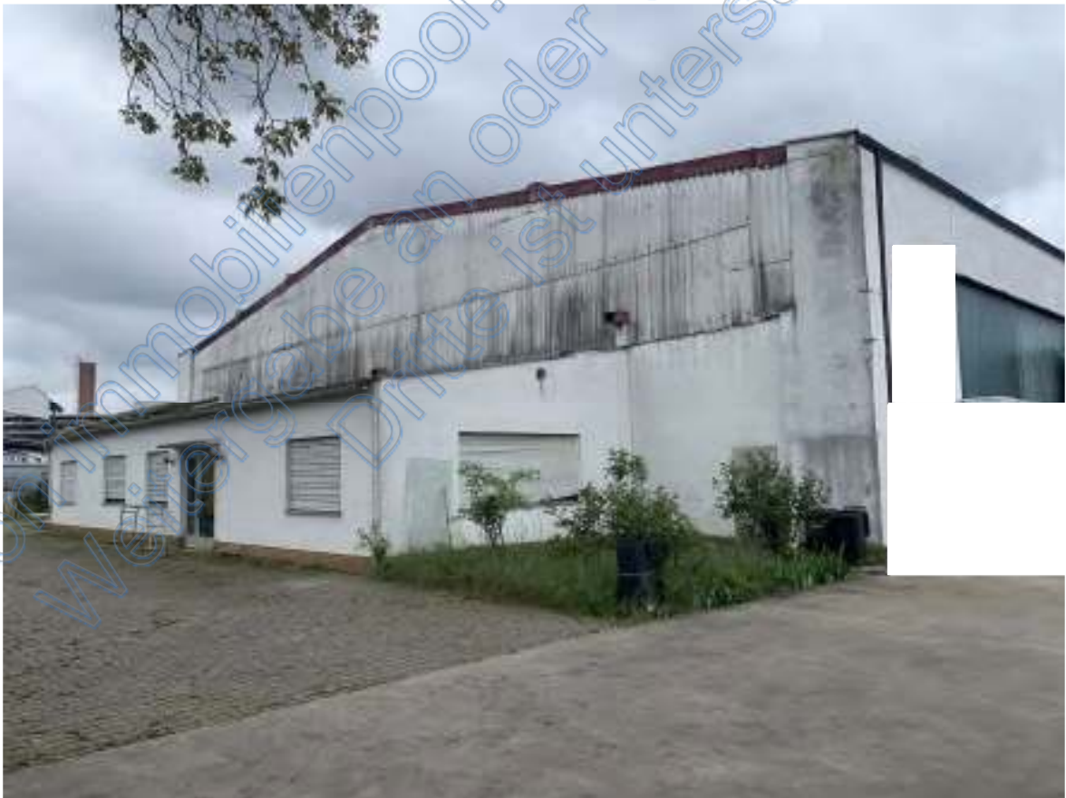
Giebelansicht von Norden
