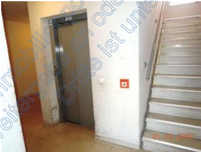
Bild 4: Flur, Treppenhaus und Aufzug
