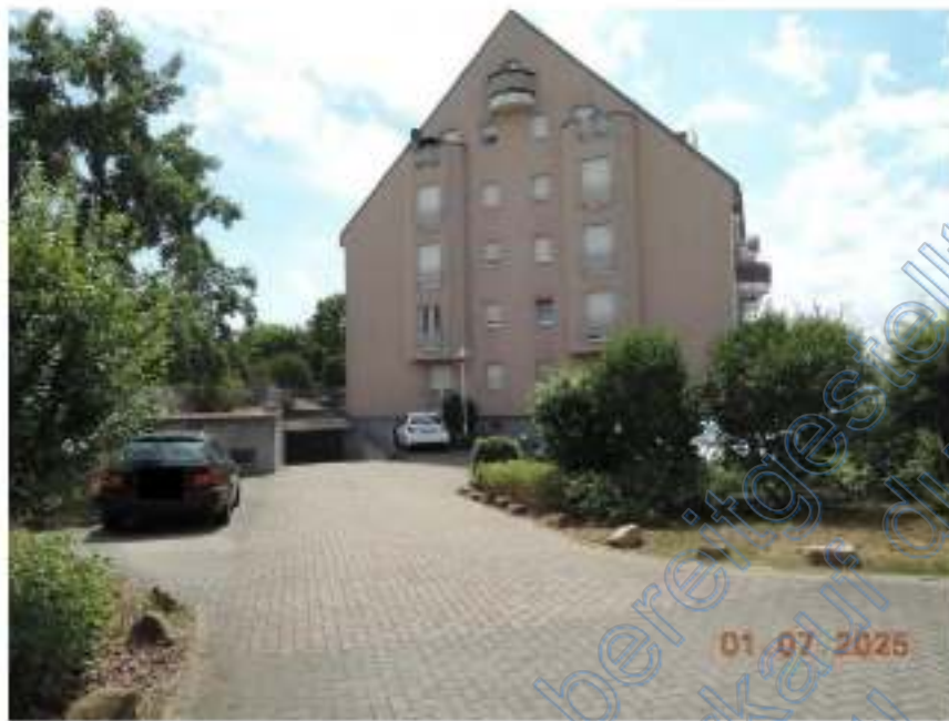
Bild 9: Giebelansicht und Einfahrt zur Tiefgarage
