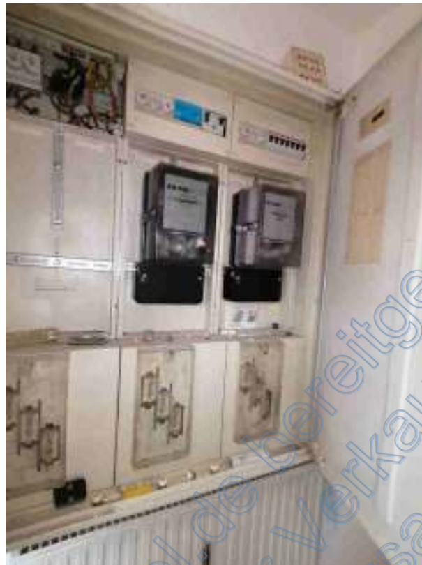
Aufnahme 7: Stromzähler (für beide WEG)
