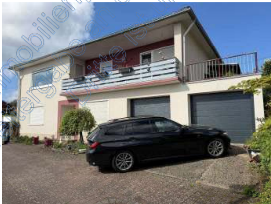
Bild 4: Blick auf das Bewertungsobjekt aus nordöstlicher Richtung
