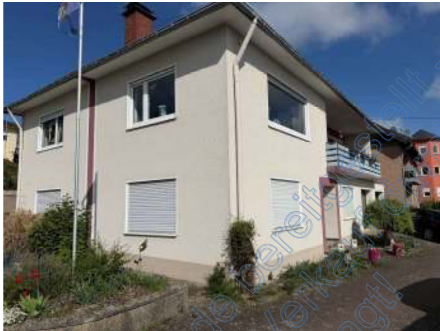
Bild 3: Blick auf das Bewertungsobjekt aus südöstlicher Richtung
