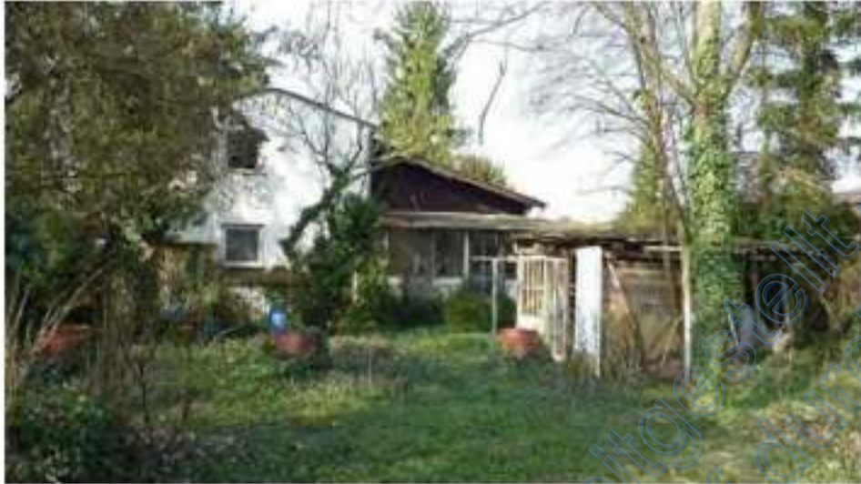
Rückansicht Wohnhaus und Holznebengebäude und Vorbauten am Wohnhaus (abbruchreif)
