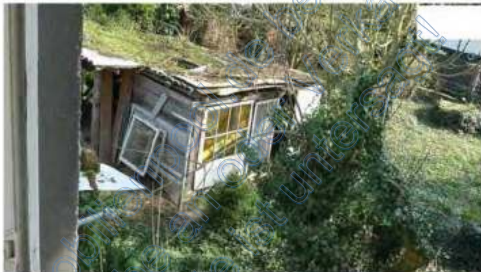
abbruchreifes rückwärtiges Holznebengebäude
