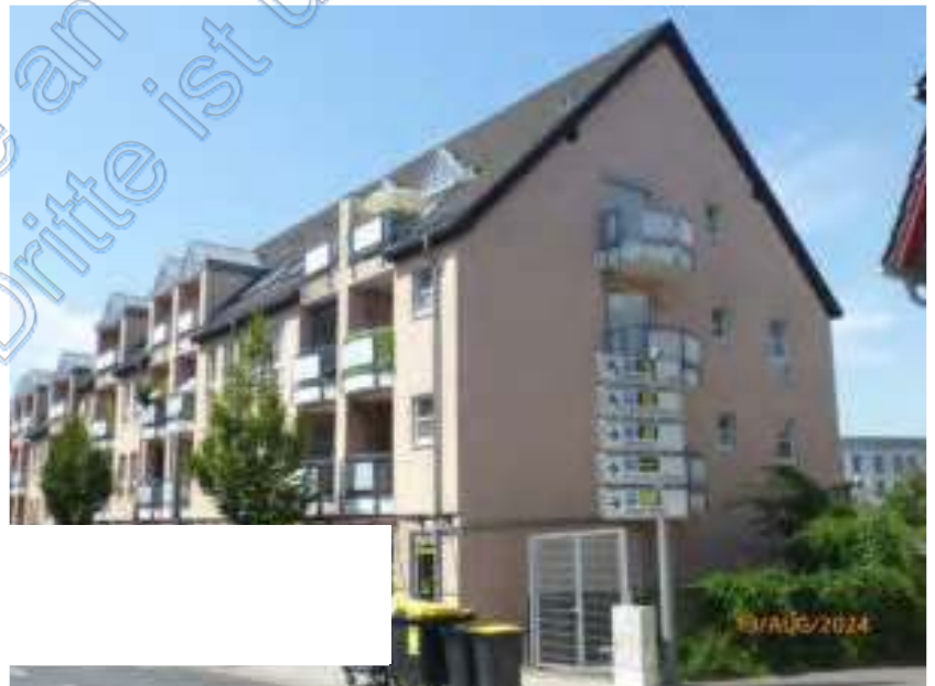
Ansicht von Süd-Osten
