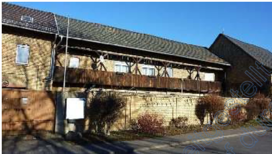
Verbindungstrakt mit Laubengang im OG
