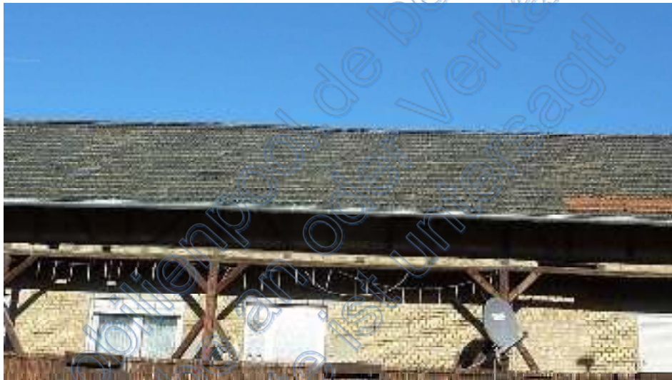
leichte Dachwelle in Dachfläche Verbindungstrakt
