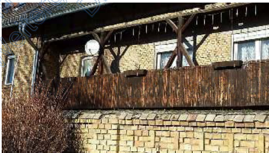
Holzteile im Außenbereich mit Abnutz.erschein.
