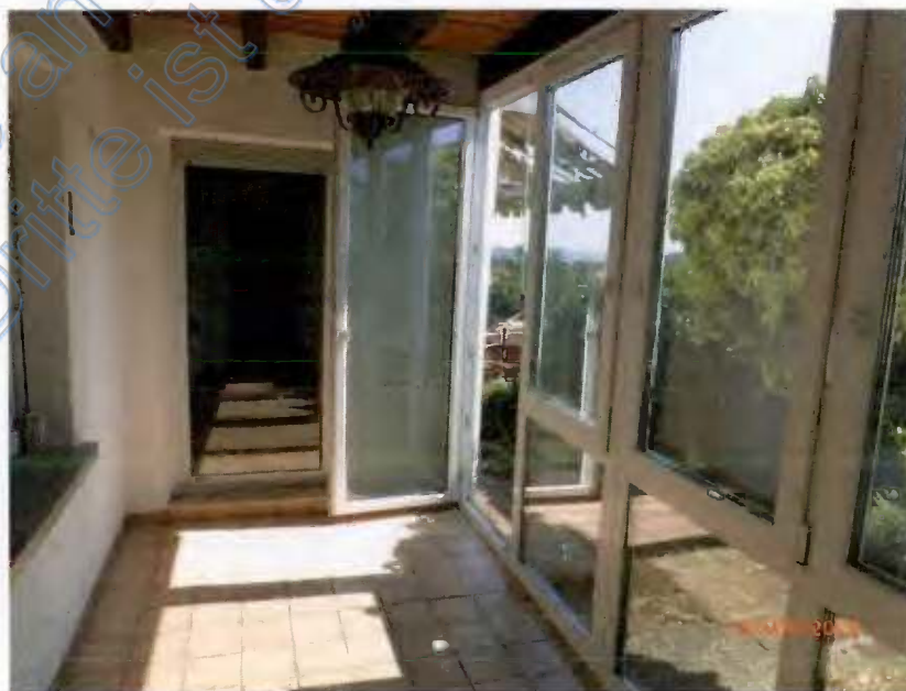
Innenansicht Erdgeschoss, Wintergarten
