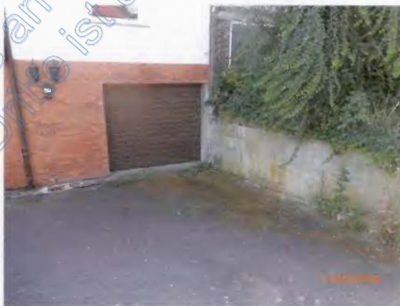
Ansicht von Nord-Osten, Garage Nr. 3
