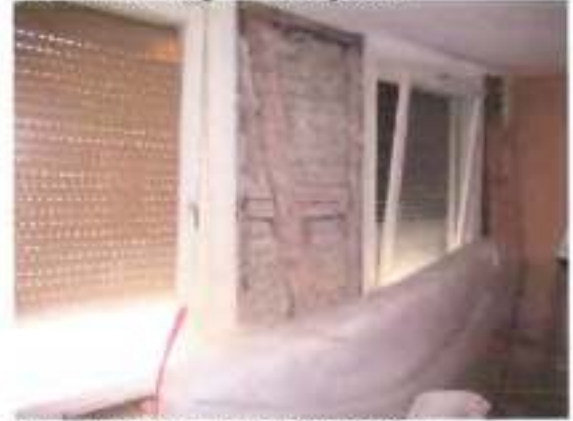
Raum im Rohbauzustand Obergeschoss
