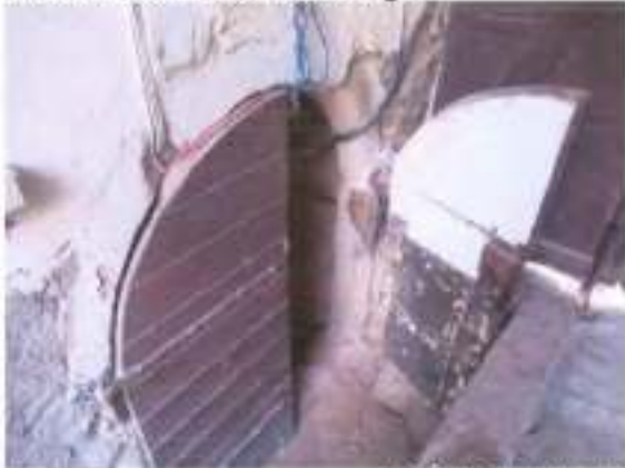
Feuchteinwirkungen mit Putzschäden im Kellerbereich
