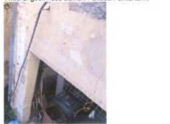
Witterungseinfluss Balken Pultdach Unterfahrt
