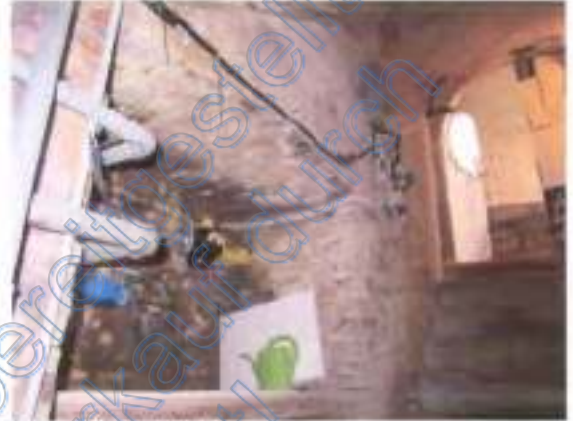
Feuchteinwirkungen mit Putzschäden im Kellerbereich
