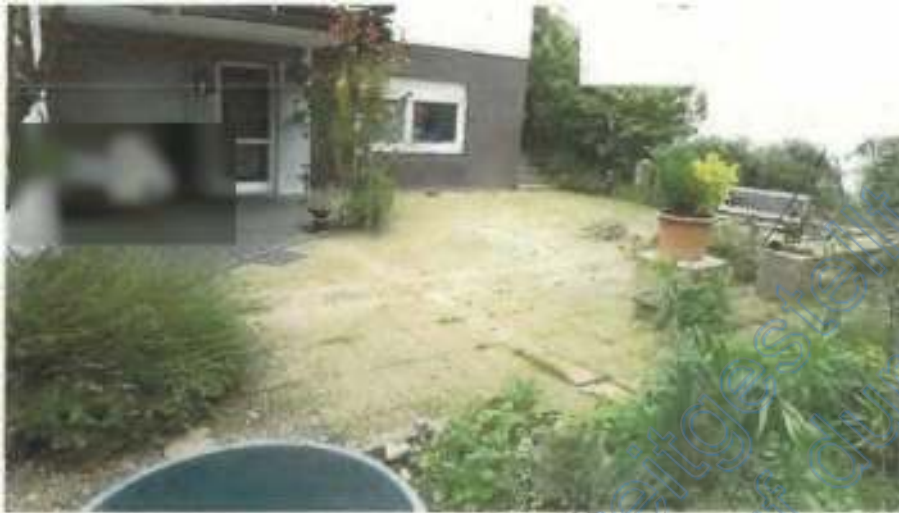
rückseitige Hof- / Terrassenbefestigung
