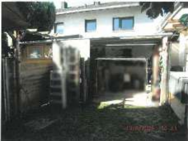
offener Unterstand an der südwestlichen Grundstücksgrenze
