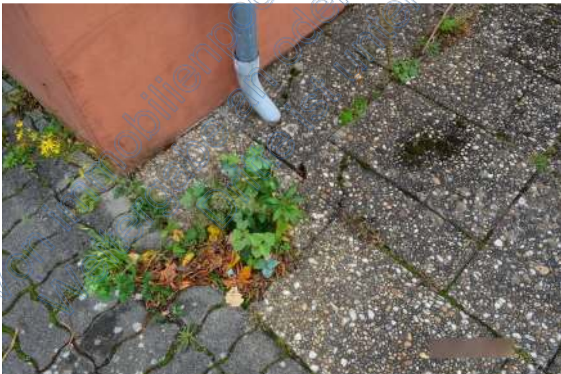
Foto Nr. 18 Dachentwässerung Westseite
