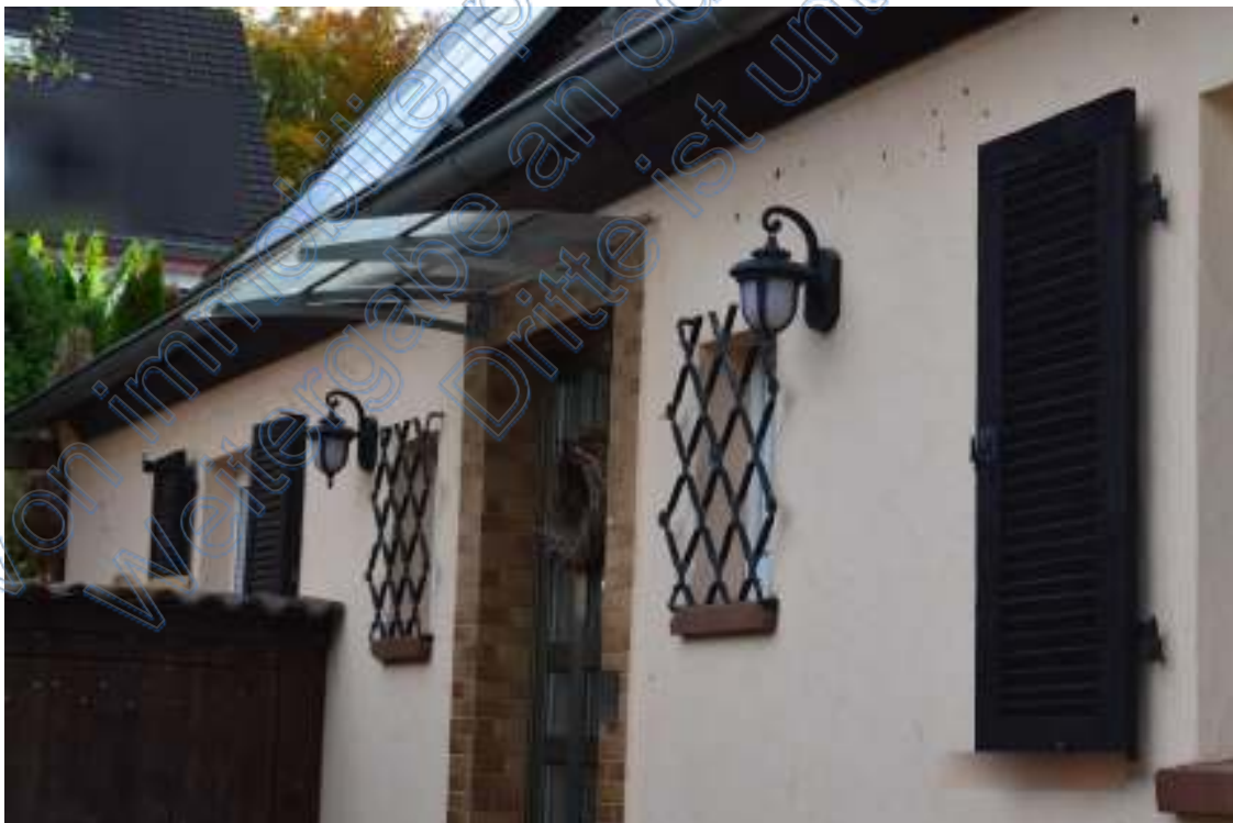
Foto Nr. 10 Ostseite / Eingangsbereich
