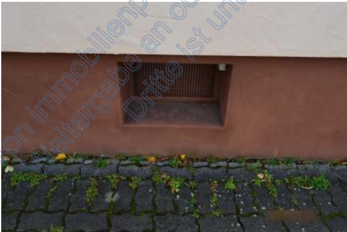
Foto Nr. 16 Kellerfenster im Straßengiebel
