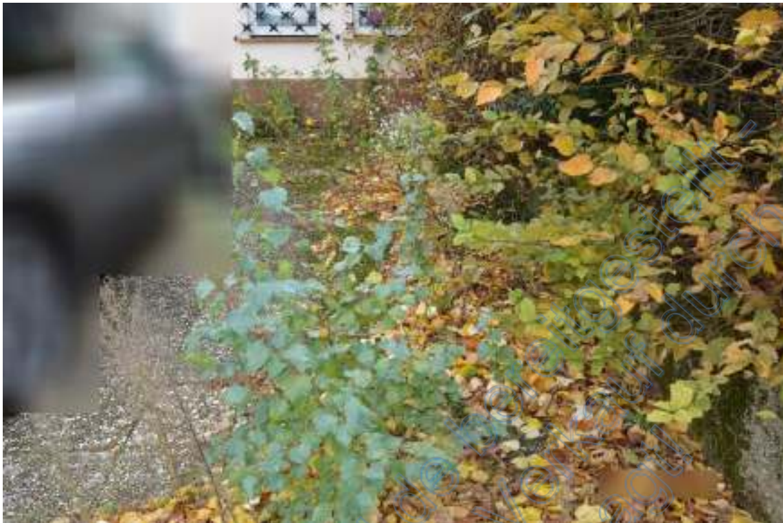
Foto Nr. 9 Fenster links (ehemalige Garage) / Geräteschuppen (vergitterte Fenster)
