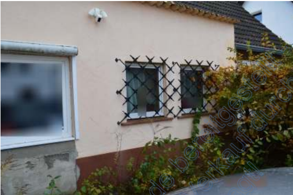
Foto Nr. 7 Fenster links (ehemalige Garage) / Geräteschuppen (vergitterte Fenster)
