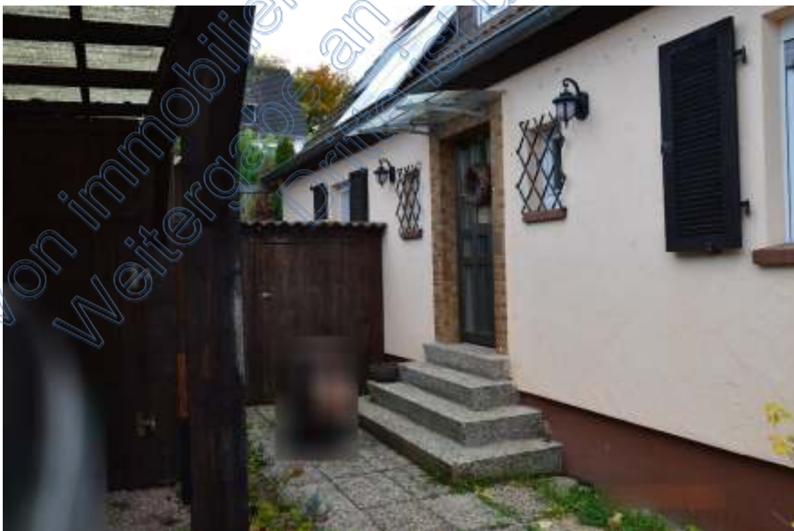
Foto Nr. 2 Ostseite Eingangsbereich
