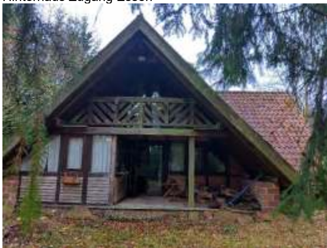
Hinterhaus Zugang Essen
