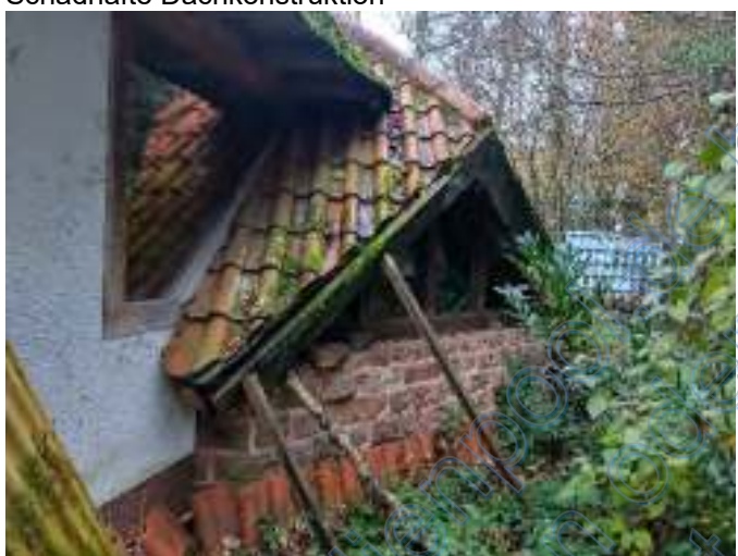
Schadhafte Dachkonstruktion
