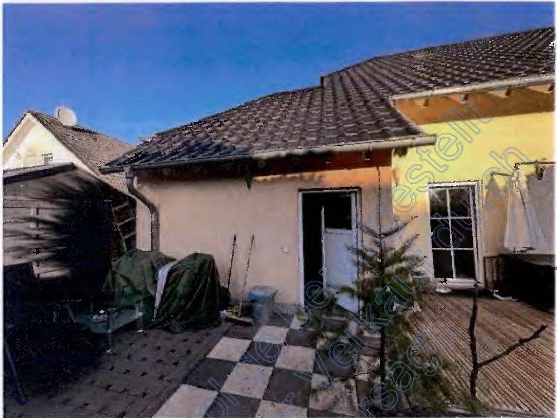
Garagenzugang vom Garten
