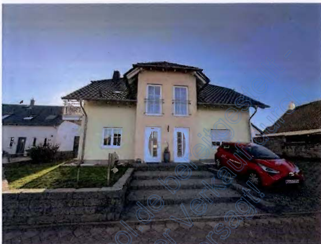
Straßenansicht von Osten
