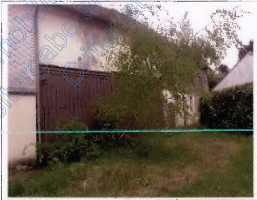
Foto 4 Hofansicht Scheunen- und Stallgebäude (Nordseite)
