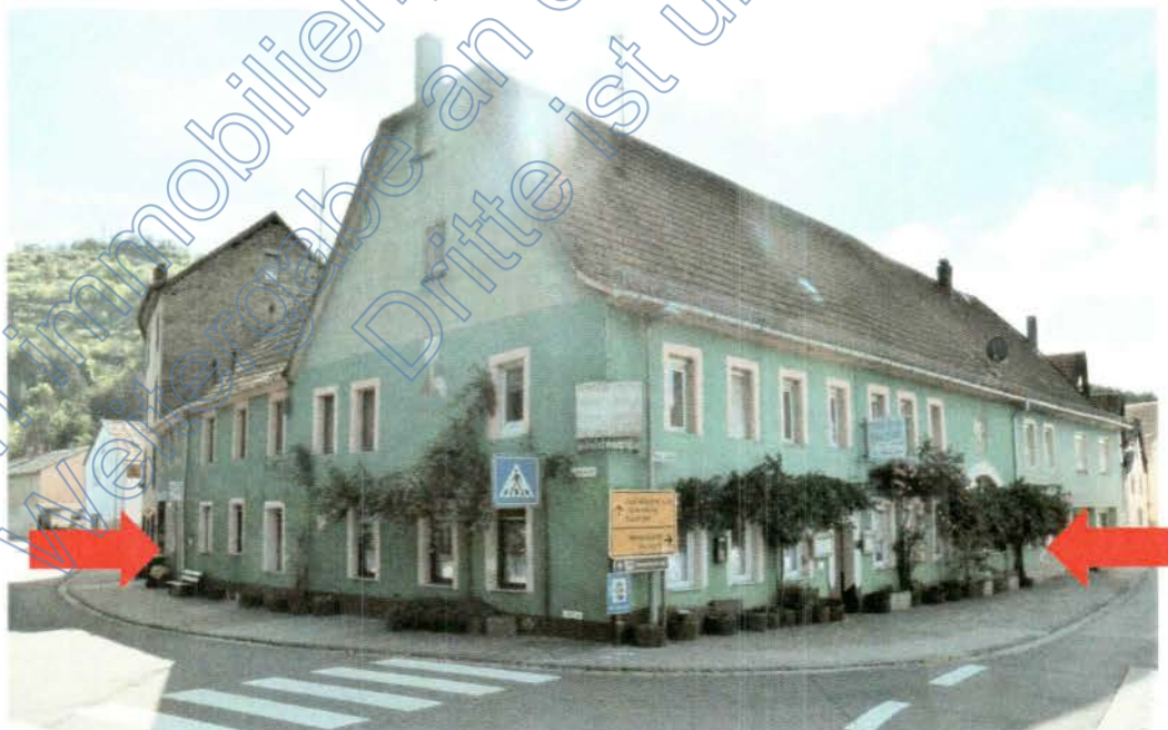
Bild 4: Blick auf das Bewertungsobjekt aus nordwestlicher Richtung
