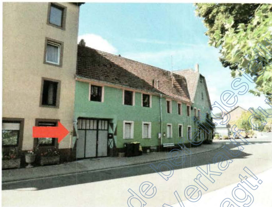
Bild 1: Blick auf das Bewertungsobjekt aus nordöstlicher Richtung
