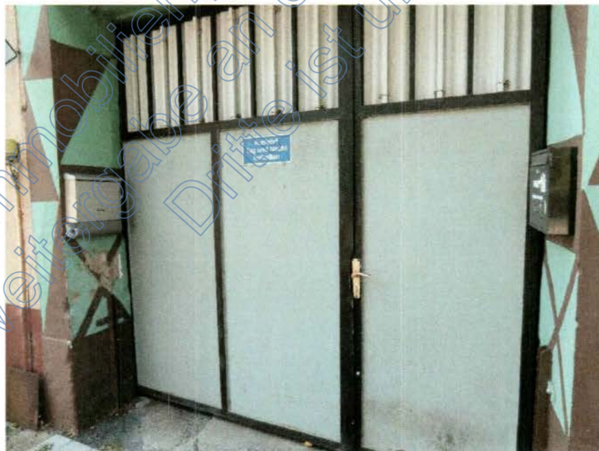
Bild 10: Blick auf das Tor zur Durchfahrt
