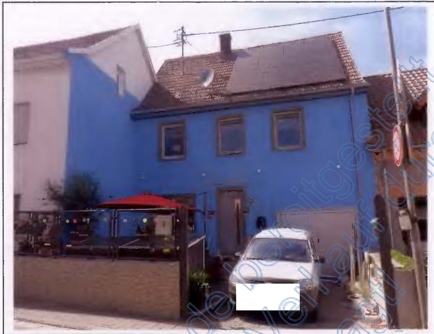
Foto 5 Hs. Nr. 62 Straßenansicht Hauseingang
