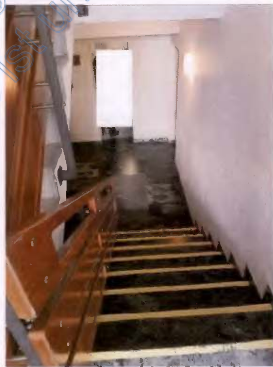
Innenansicht Treppenhaus (zum Keller)
