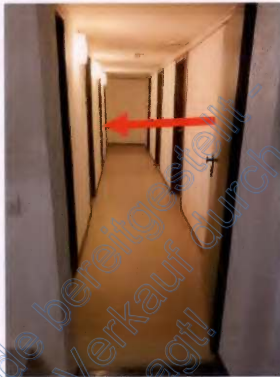
Keller: Gang, der zum Hobby- und Abstellraum führt
