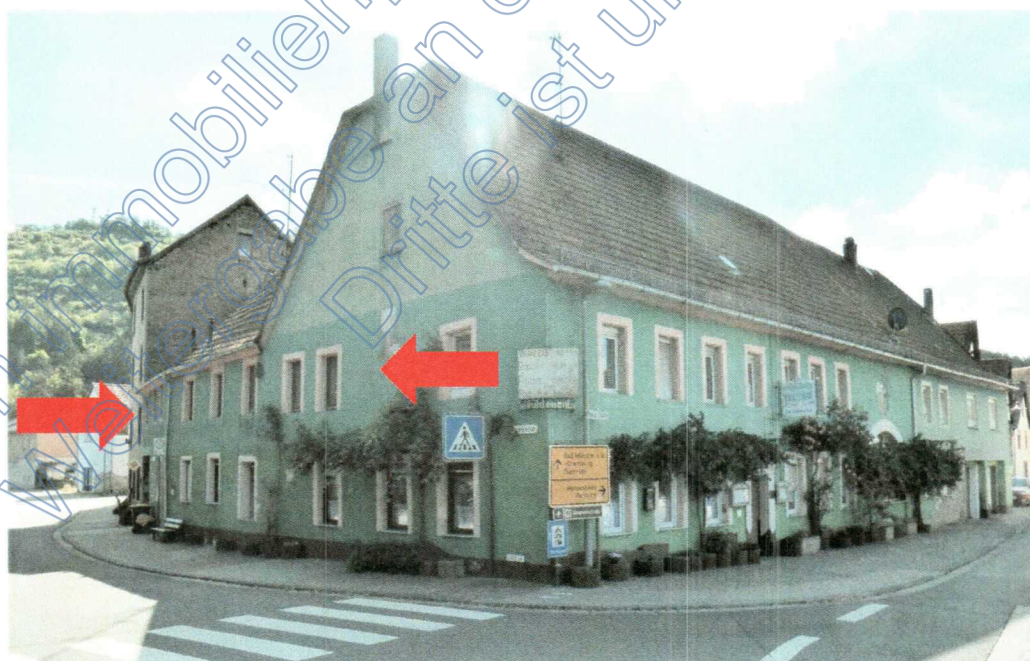
Bild 4: Blick auf das Bewertungsobjekt aus nordwestlicher Richtung
