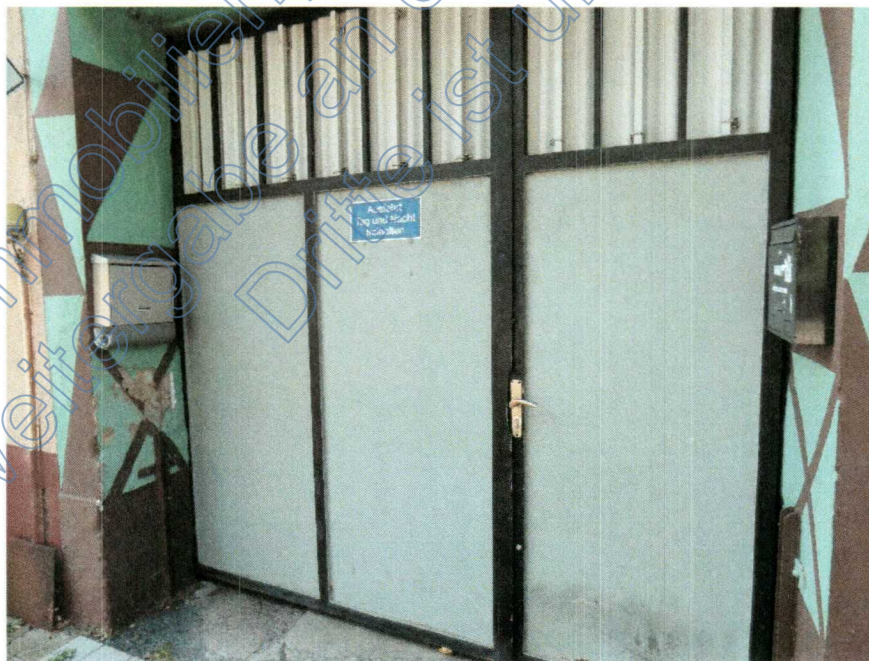
Bild 10: Blick auf das Tor zur Durchfahrt
