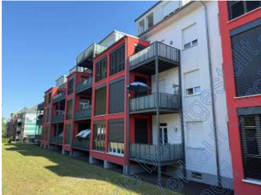
Bild 3: Blick auf einen Teilbereich der Wohnungseigentumsanlage aus südwestlicher Richtung
