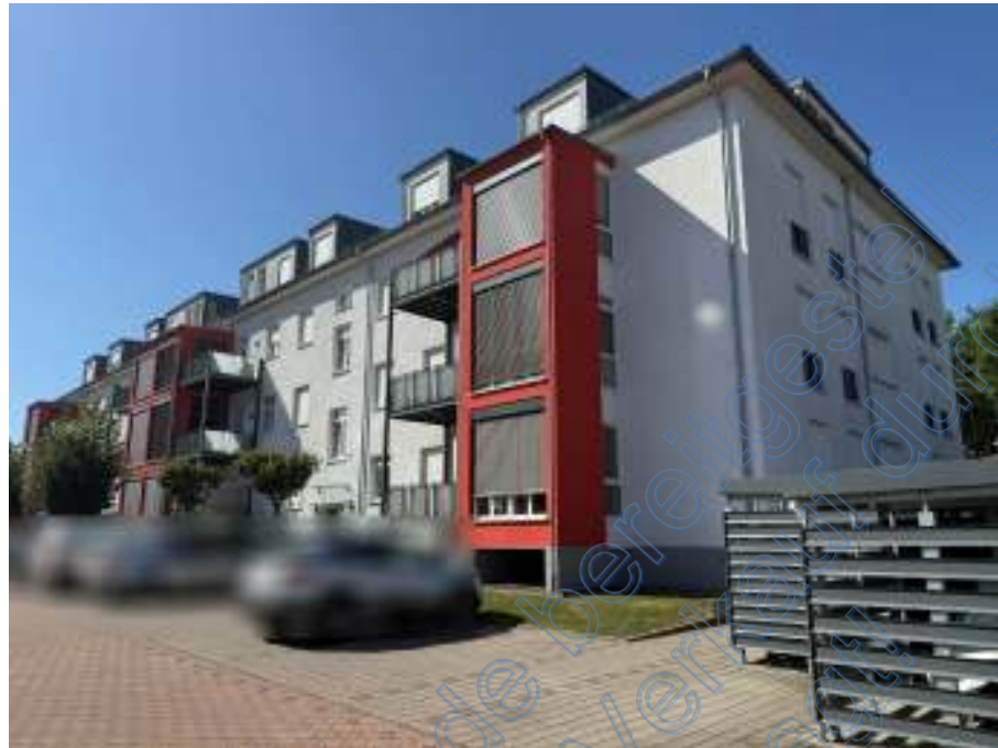
Bild 1: Blick auf die Wohnungseigentumsanlage aus nordwestlicher Richtung
