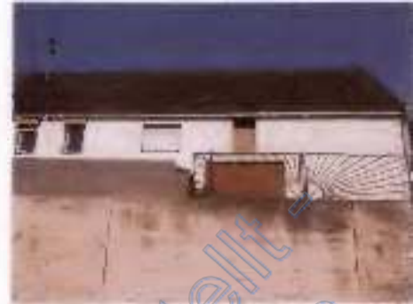
Süd-Ost-Ansicht von der tieferliegenden Hauptstraße L 376
