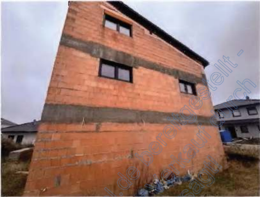
Giebelansicht von Westen
