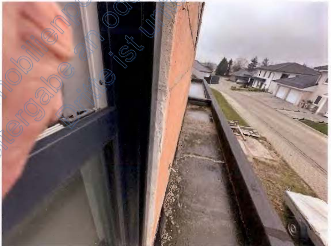
Vordach über Eingang
