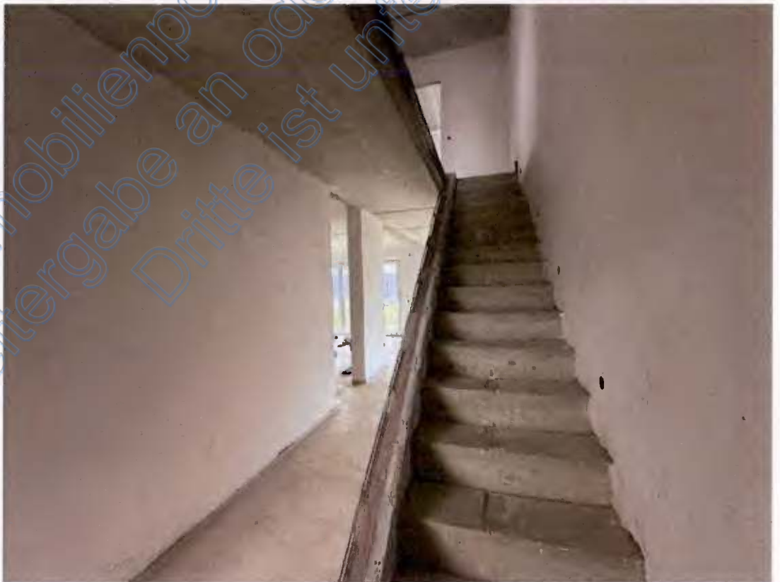
Treppe EG - OG
