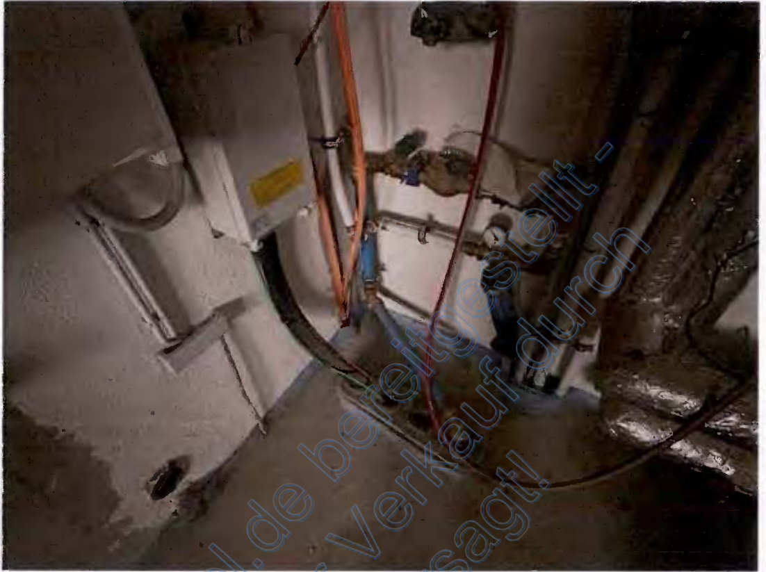
Mehrsparte Hausanschlüsse
