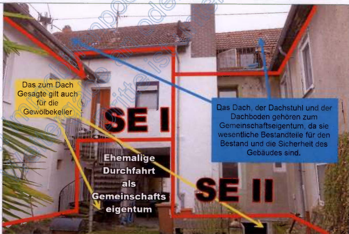
Hofansicht mit Einkizzierung der Grenzen gemäß Aufteilungsplan sowie Anmerkungen zu Dach und Gewölbekeller!
