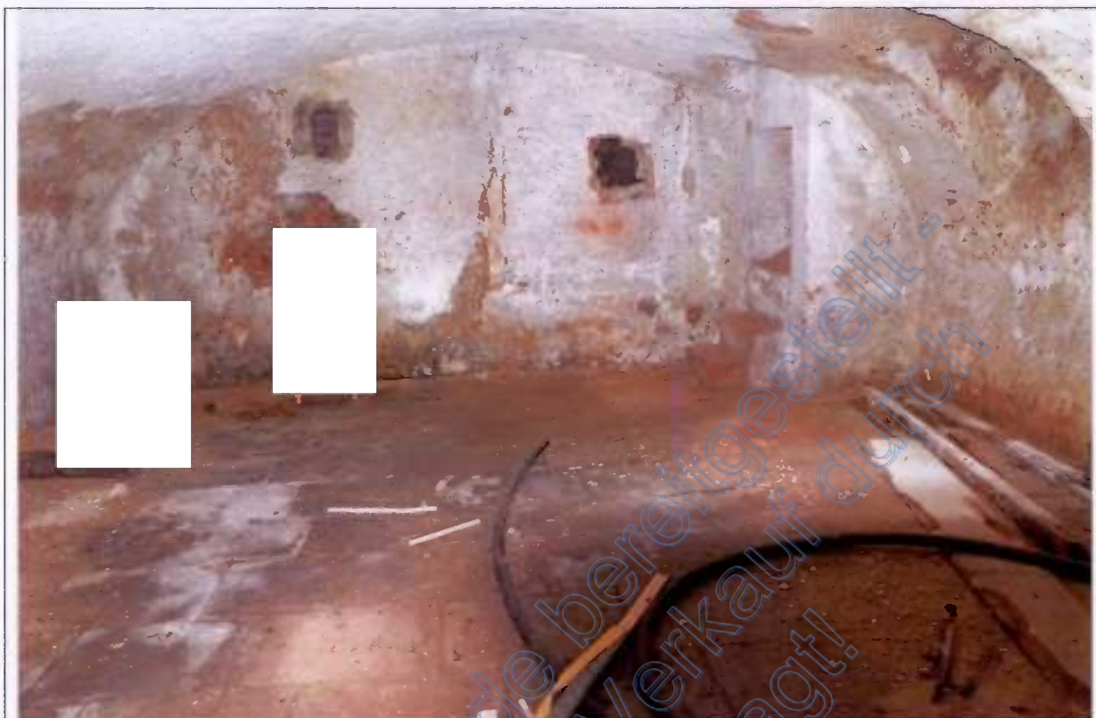
„Gewölbekeller“ unter SE I (rechts)
